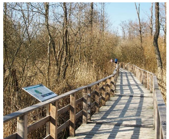
Neue Moorwanderwegbrücke im Tunneltal
